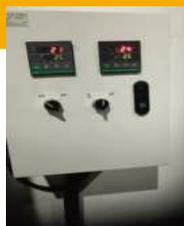
在冷卻塔電箱處加裝溫度控制器，通過設定冷水機組冷卻水進水溫度，自動控制冷卻塔風機啟停。經改造後跟蹤，**平均每天節約電量98kWh，年節能量1.47噸標煤，年經濟效益0.93萬元**。
